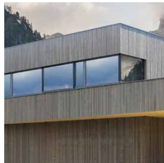
○ Montage einer vorvergrauten Fassade im Jahr 2017
